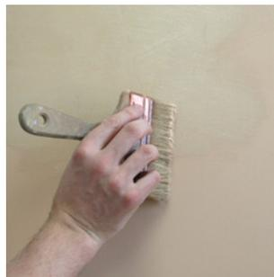
Широкой кистью наносите «Art» выбранного цвета разнонаправленными крестовыми движениями, получая желаемый рисунок. Наносить слоем, необходимым для перекрывания подложки.
