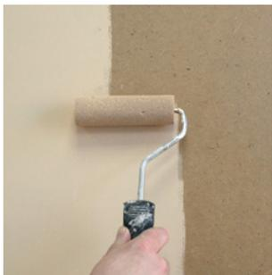
Подготовьте поверхность, прогрунтовав ее «Mestica 2», нанесите один слой подложки «Base», лучше отколерованной в контрастный, более темный цвет, но гармонирующий с основным цветом материала.
