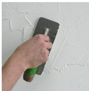
Металлическим шпателем, методом приглаживания к поверхности «лопухами», наносим Rilevato.
