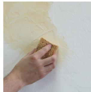
Материалом Pastello Mediterraneo, колерованным в более светлый цвет, с помощью обычной губки покрываем всю поверхность.
