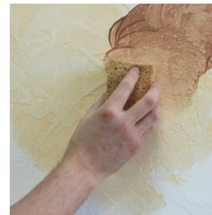
Колерованную в более темный, но гармонирующий с первым цвет, Pastello Mediterraneo с помощью губки наносим всю поверхность.
