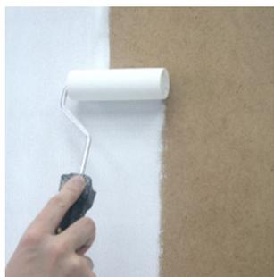
Подготовка поверхности материалом Rugoso Muro с помощью короткошерстного валика.
