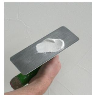
Металлическим шпателем набираем небольшое количество материала Rilevato.
